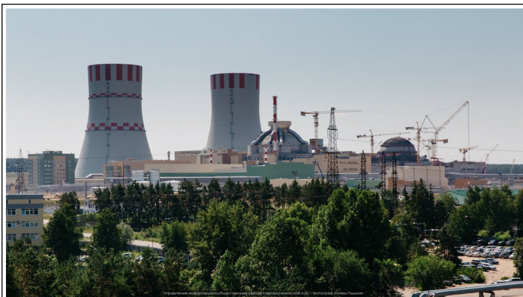
Staveniště Novovoronežské jaderné elektrárny. (Zdroj: Rosatom)
